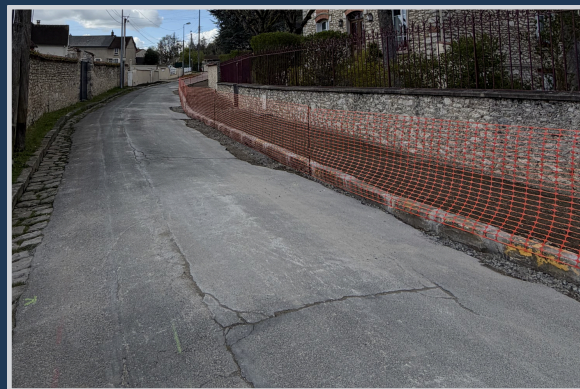
Chantier rue de Mespuits
