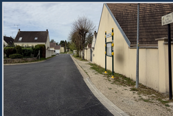
Rue des Tilleuls après les travaux
